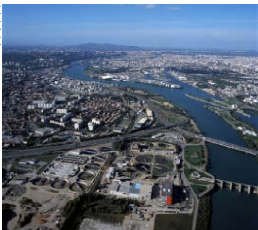
Vue aérienne de la station d'épuration (photo Grand Lyon)
