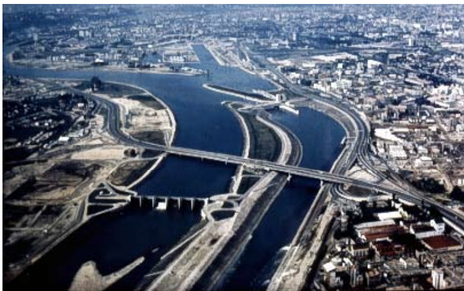
Vue aérienne de l'aménagement de Pierre-Bénite (photo C.N.R.) : canal, barrage, usine hydroélectrique
